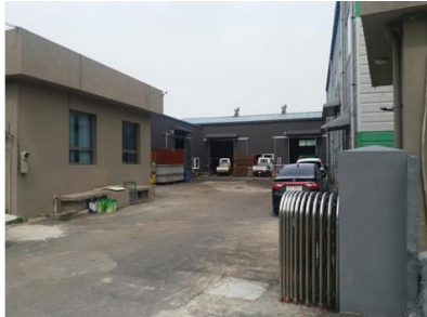
제1공장 : 광주광역시 오선동 546-1 - 250kW급 지붕형 태양광 발전소 설치 예정 - 840kWh 태양광 연계 ESS 운영예정
